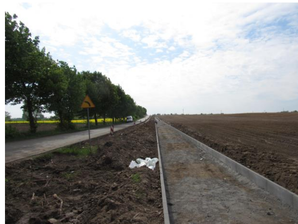
Fot.45, 46. Kolejne warstwy konstrukcyjne na ścieżce pieszko-rowerowej w ciągu drogi.
