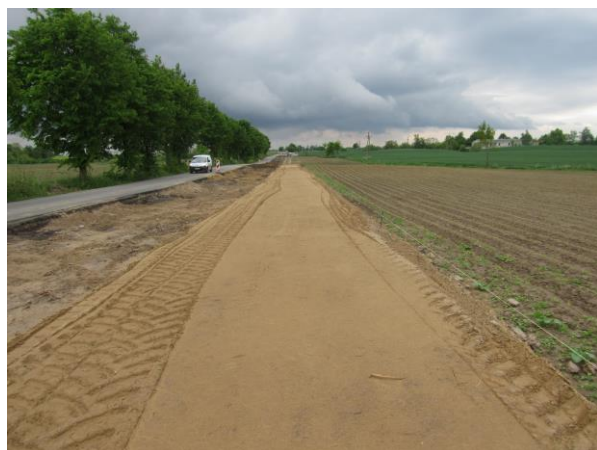
Fot.45, 46. Kolejne warstwy konstrukcyjne na ścieżce pieszko-rowerowej w ciągu drogi.
