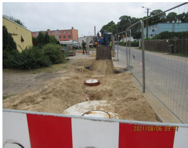
Fot. 5,6. Prace budowlano-montażowe przy budowie nowej sieci wod-kan w Wojnowie.
