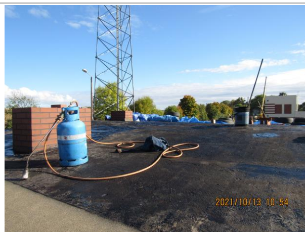
Fot.36 i 37. Wykonano nowe sieci przybriektowe oraz ocieplenie i pokrycie dachu.
