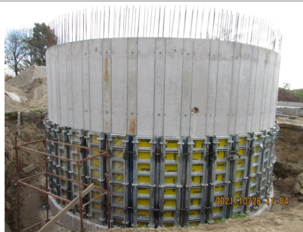
Fot.30. Zbiornik beztlenowy w budowie - ob. nr 7
