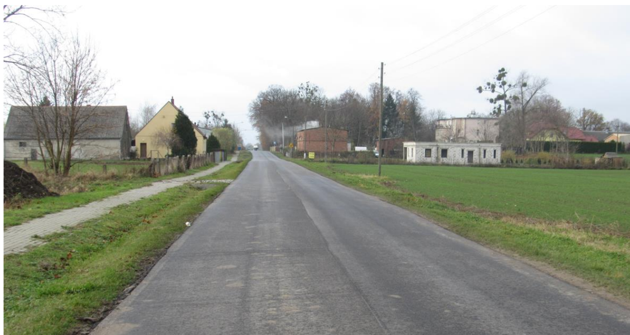
Fot.82. Nakładka bitumiczna na drodze powiatowej – odcinek Gliszcz – Trzemiętowo.
