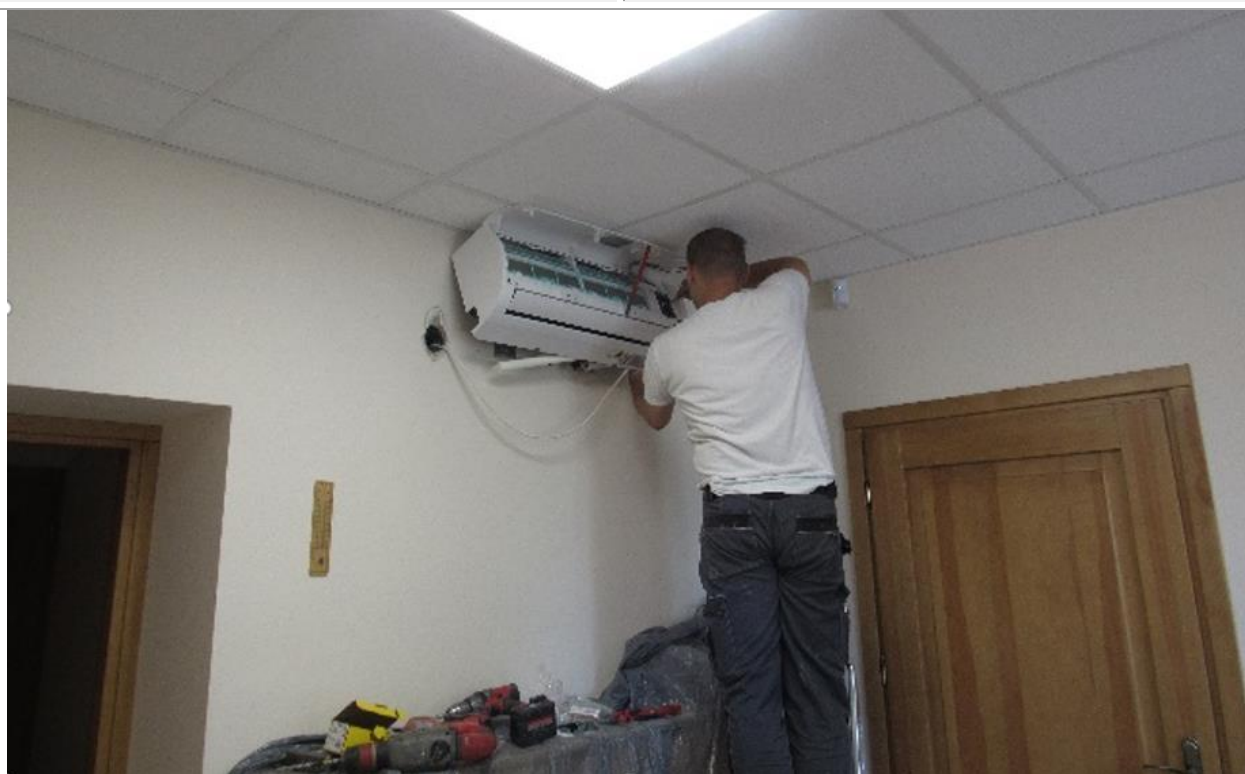
Fot.86. Montaż urządzenia wewnętrznego w budynku UG na ul. Sportowej 2
