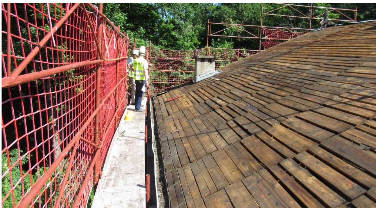
Fot.89. Sprawdzanie stanu technicznego odkrytego deskowania dachu na budynku w Mochlu.
