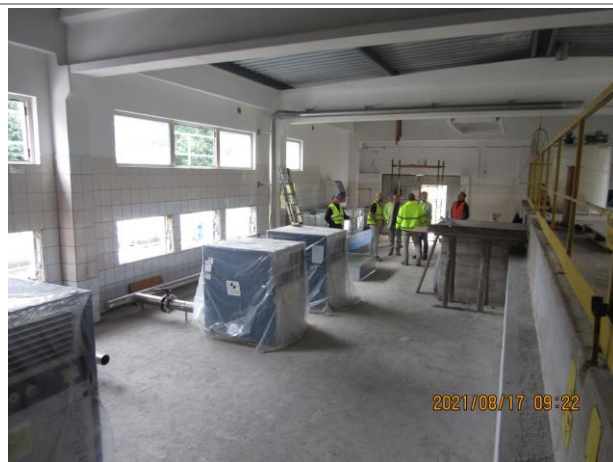
Fot. 25 i 26. Stacja dmuchaw i stacja mechanicznego oczyszczania ścieków w trakcie montażu.
