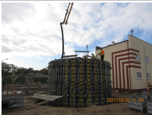
Fot.29. Betonowanie zbiornika uśredniająco-zakwaszającego - ob. nr.5
