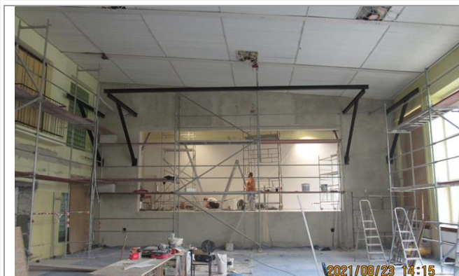
Fot.122. Modernizacja sceny i konstrukcja pod trawersy.
