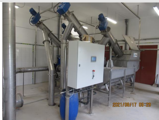
Fot. 25 i 26. Stacja dmuchaw i stacja mechanicznego oczyszczania ścieków w trakcie montażu.
