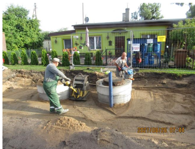
Fot. 5,6. Prace budowlano-montażowe przy budowie nowej sieci wod-kan w Wojnowie.
