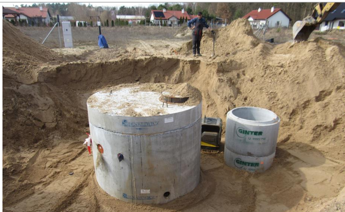
Fot. 10. Prace budowlano-montażowe przy budowie kanalizacji na ul. Promykowej w Kruszynie.
