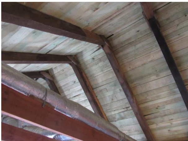
Fot.97. Nowe deskowanie na całej połaci dachu.
