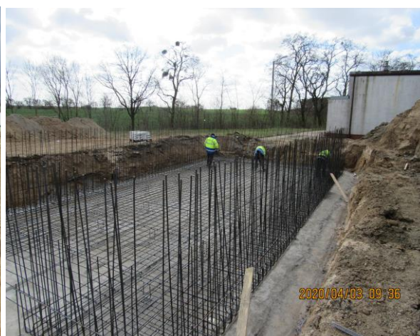
Fot.20. Zbrojenie pod reaktor biologiczny.
