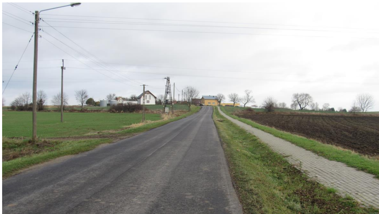
Fot.83. Nakładka bitumiczna na drodze powiatowej – odcinek Gliszcz – Trzemiętowo.
