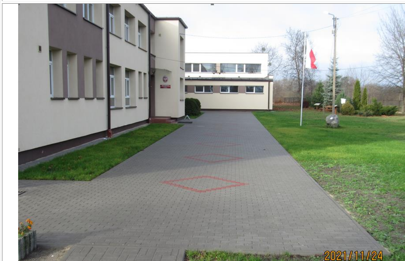
Fot. 128. Nowe utwardzenie terenu z odwodnieniem przed frontem budynku SP w Strzelewie.
