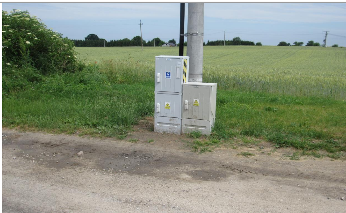
Fot.153. ZKP i szafka oświetleniowa do oświetlenia na skrzyżowaniu dróg w Nowaczku.
